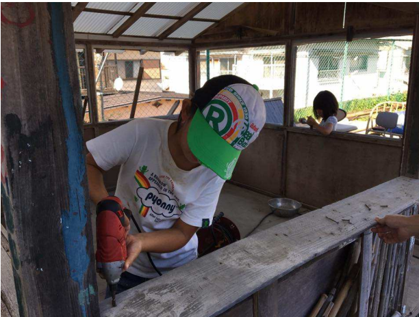
普段は触れない機械で小屋を解体
